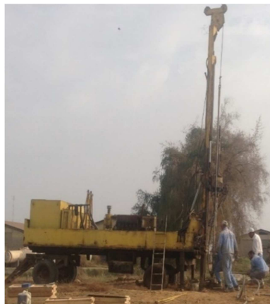
شکل ۱: دستگاه حفاری Mobil Drill XY.
